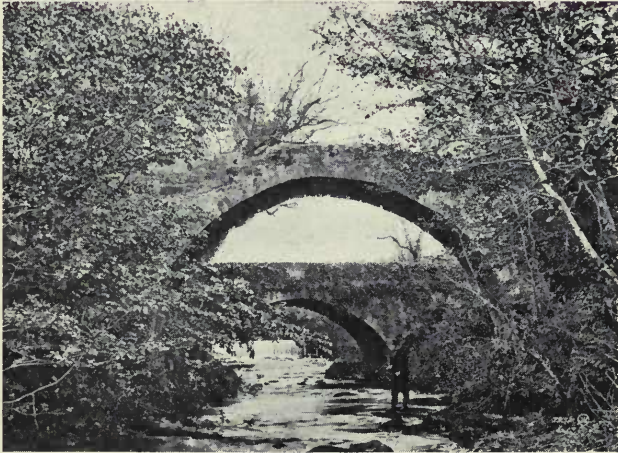
“Roman” Bridge, Inverkip
